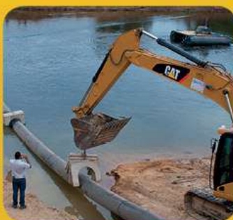
Execução de obras de infraestrutura, incluindo sistema de esgotamento sanitário e construção de travessia subaquática - Barreiras - Ba
